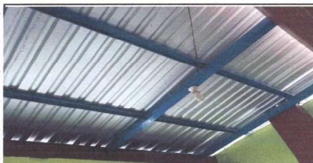
Foto 5: TECHO DE LA COCINA ESCOLAR FINALIZADO
