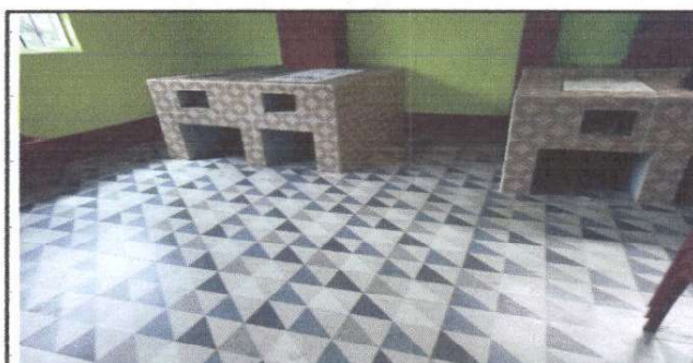
Foto 6: PLANCHAS Y PISO DE LA COCINA FINALIZADO
