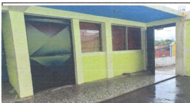
Foto 4: PINTURA DE MUROS TANTO INTERIOR COMO EXTERIOR FINALIZADO
