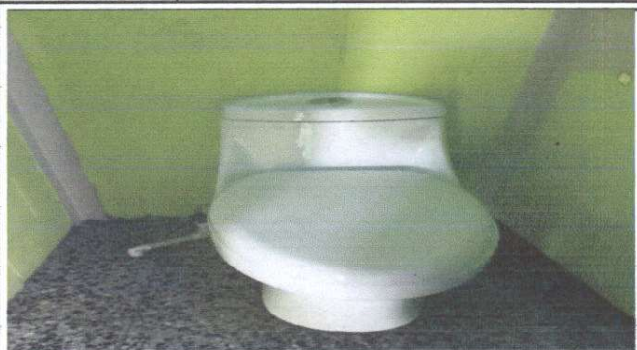
Foto1: TAZAS DE SANITARIOS FINALIZADO
